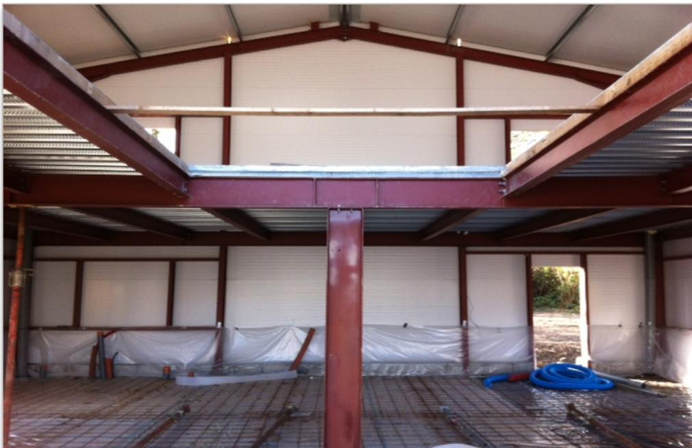
**ATTENTION:** avant de couler un plancher collaborant ou n'importe quel type de dalle, il faut préalablement que l'entreprise de Gros-œuvre mette en place des étais sous la totalité du plancher : traverses de planchers, solives.
