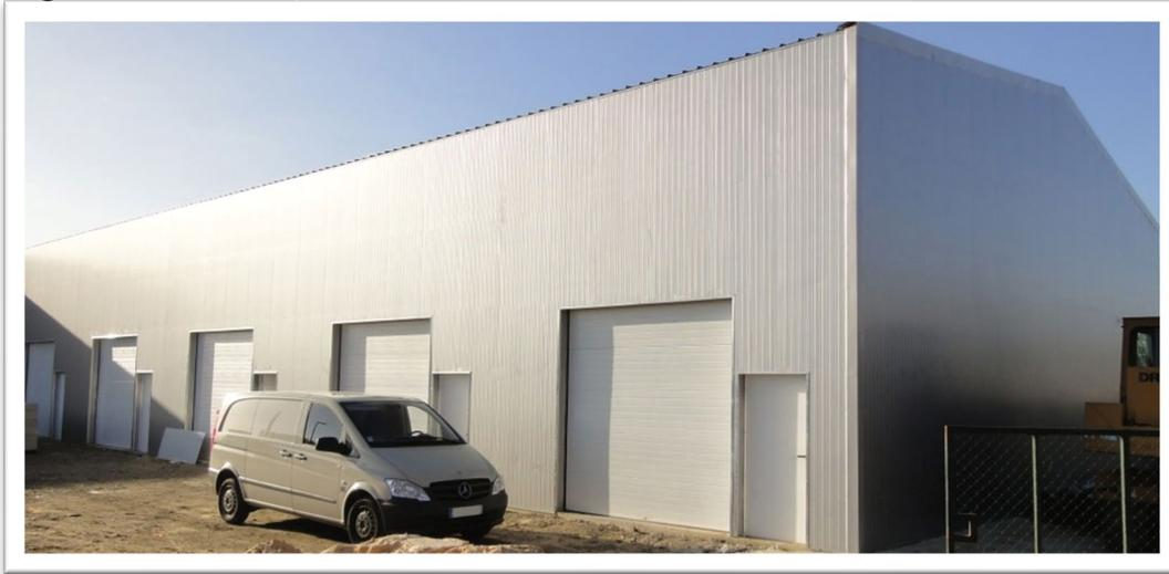
Les tôles de bardage en pignon se fixent sur les lisses, et en partie haute sur la cornière prévue à cette effet.
